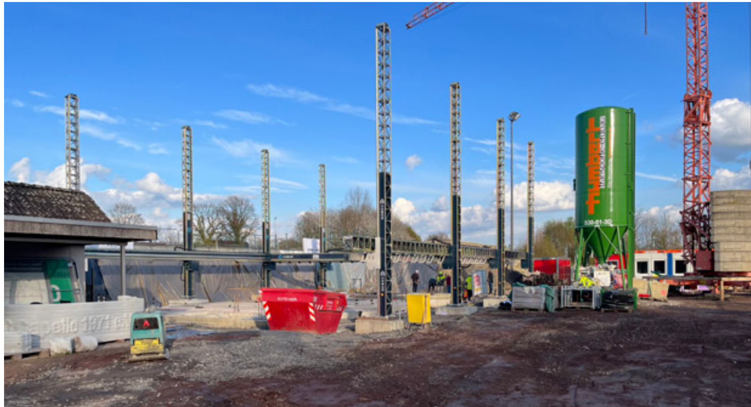
Schicht für Schicht errichtete der Drucker den Bau in 140 Stunden
